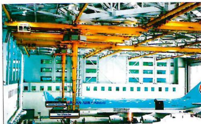
Рис. 7. Поворотные платформы обслуживания на телескопических колоннах
