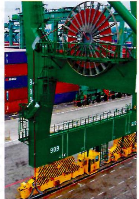
Рис. 1. Кабельный барабан на STS-кране (портовый контейнерный перегрузатель)
