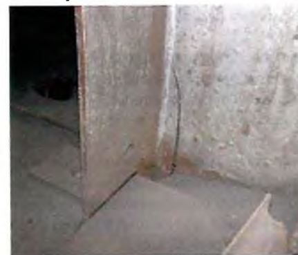
Рис. 4. Переход трещины с поясного листа на стенку колонны
