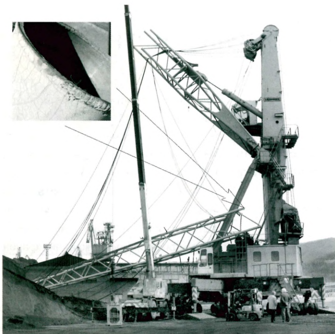
Рис. 2. Разрушение стрелы портального крана
