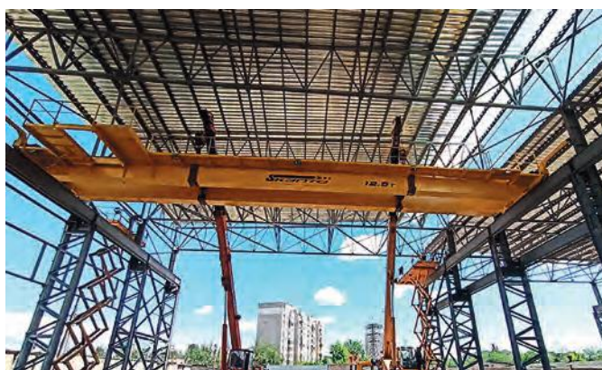
Монтаж крана мостового двухбалочного
