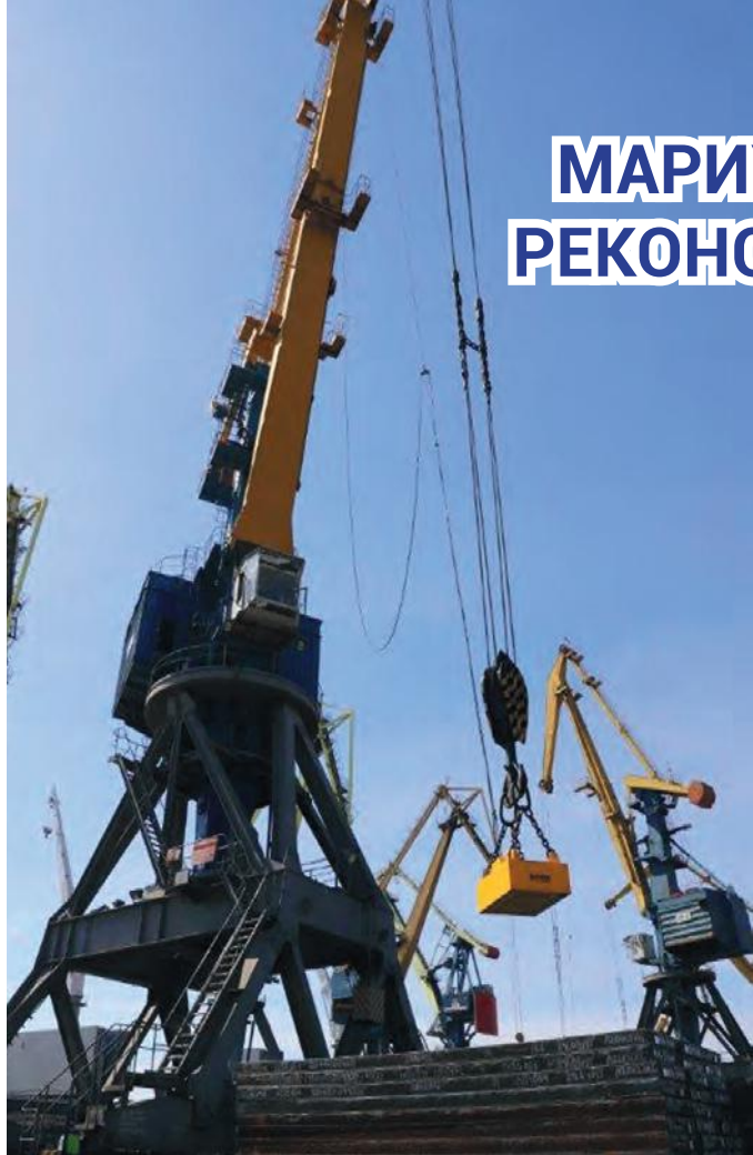
Портальный кран "Кондор" № 10 после реконструкции
