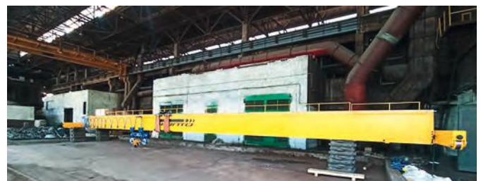
Монтаж мостового крана
