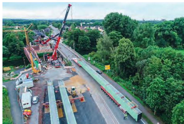
Транспортировка тяжелых стальных мостовых ферм трейлерами к существующему 70-летнему мосту на реке Липпе
