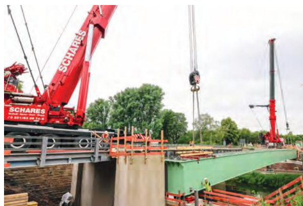
Стальные фермы моста весом 168 тонн аккуратно устанавливаются на опоры береговых устоев моста
