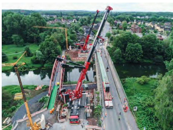
Тандемный подъем груза мобильными кранами Liebherr LTM 1500-8.1. При этом крюк каждого крана воспринимает нагрузку в 84 т
