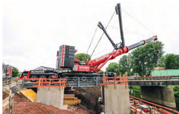
Опираясь на бетонный фундамент, специально сделанный для выполнения грузоподъемных операций, краны поднимают и перемещают груз с тяжелых транспортных средств в нужное положение, чтобы предотвратить повреждение существующего моста
