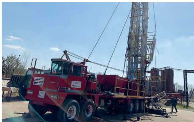
Заміна штоку гідроциліндра 190x170x7100x7100x15950 (загальний габарит) для мобільного бурового комплексу МБК-200
