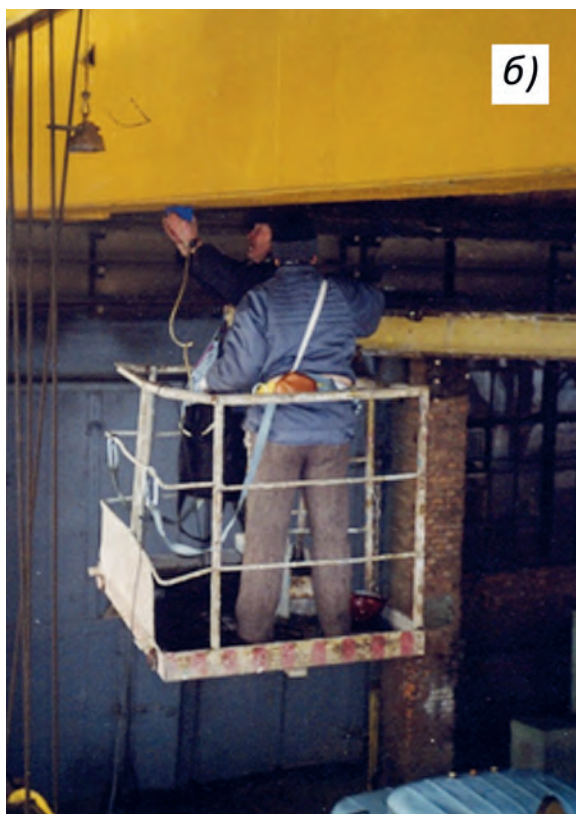
Рис. 6 Рабочие моменты проведения контроля состояния металлоконструкций специалистами ООО «ПромТехДиагностика» (сверху) и ООО «Подъем-Сервис» (внизу) с применением коэрцитиметров КРМ-Ц-К2М: а) боковой стенки главной балки; б) нижнего пояса главной балки
