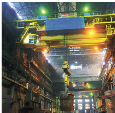
Крани мостові електричні
