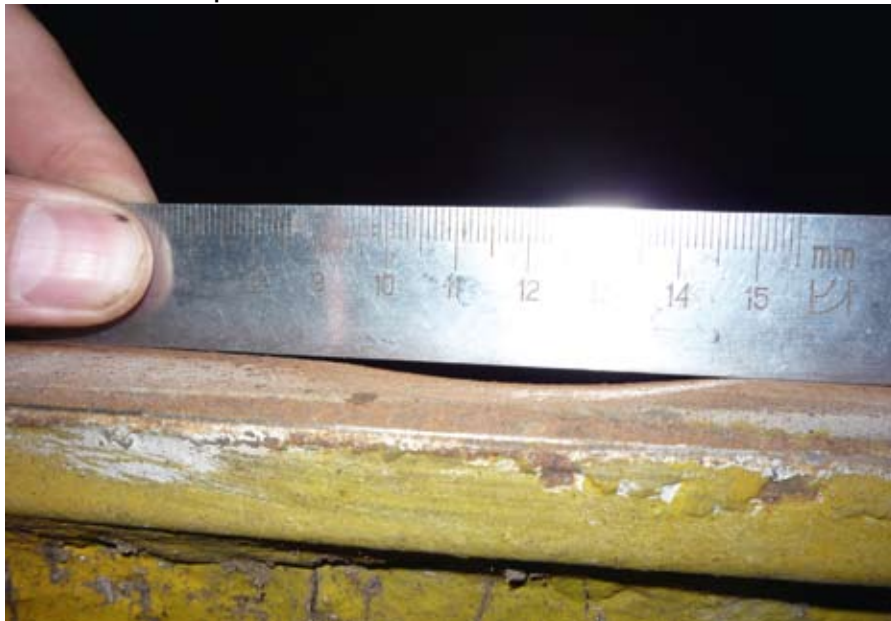
Рис 2. Износ головки рельса
