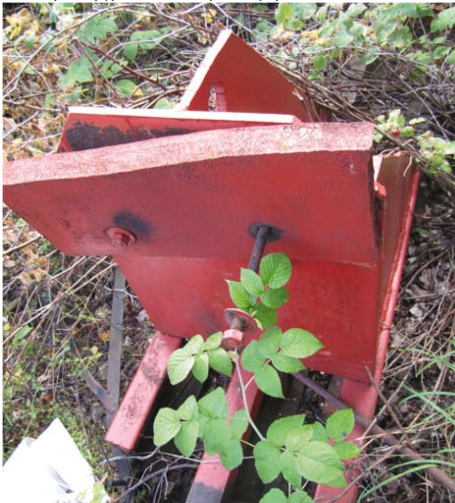
Рис. 1. Отсутствие упругого элемента на тупиковом упоре
