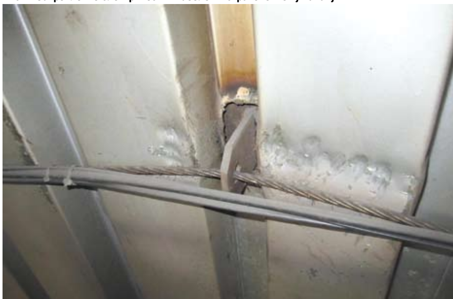
Рис. 4. Закрепление электрических кабелей к страховочному канату
