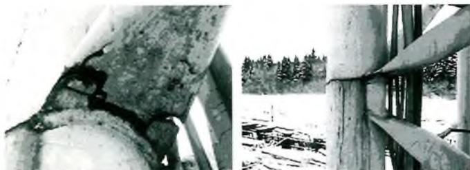
Рис. 3. Опоясывающая трещина несущего пояса башни КБ-572А
