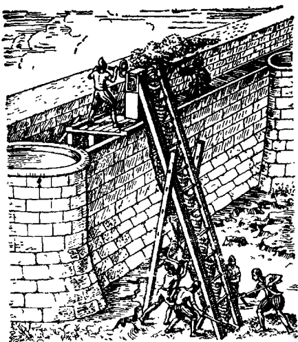
Рис 2 Применение ковшового элеватора с ручным приводом при строительстве крепости
