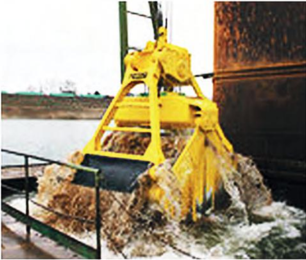
Рис. 7 Грейфер фирмы SMAG для проведения дноуглубительных работ
