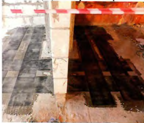
Рис. 1. Усиление конструкций монолитной плиты перекрытия на участке опирания
