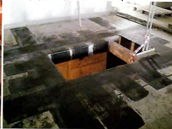
Рис. 2. Усиление конструкций плиты перекрытия в месте устройства дополнительного проема
