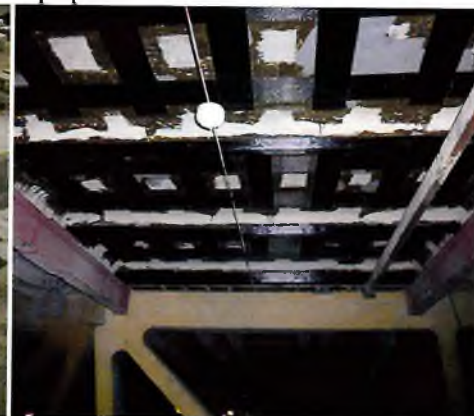
Рис. 3. Усиление сборной плиты перекрытия
