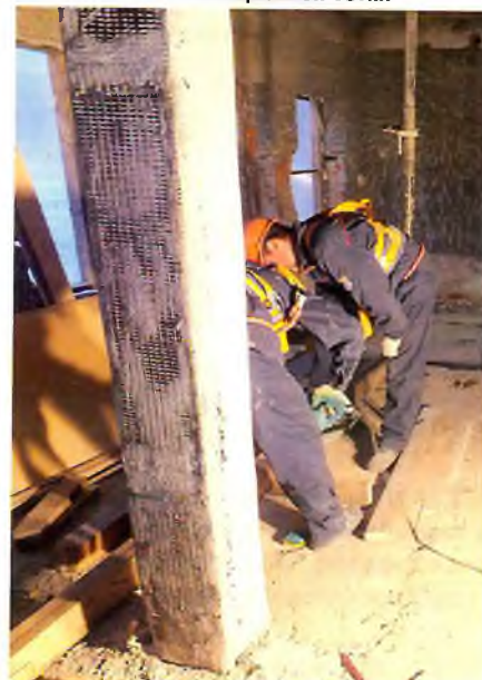
Рис. 4. Устройство «обоймы» вокруг колонны из композиционной сетки
